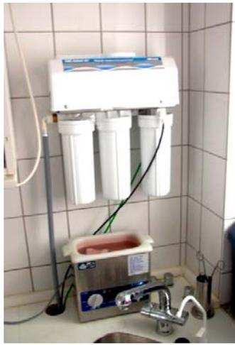
automatisch das demineralisierte Wasser, das sich die Autoklaven dann selber aus dem Vorratsgefäß herauspumpen. Eine sehr komfortable Art der Wasserversorgung!
